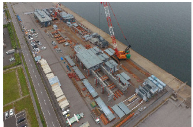
組立状況 (富津市)
