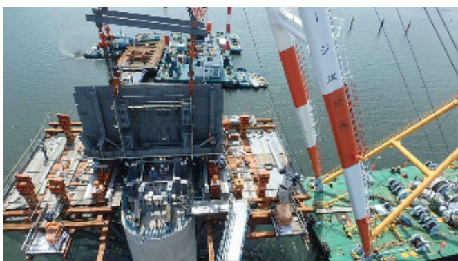
P4橋脚柱頭部架設状況
