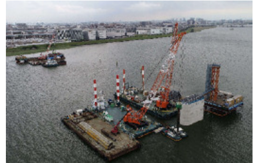
P4橋脚全景 (鋼管矢板切断後)
