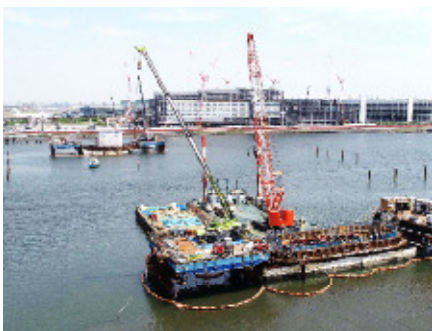
P3・P4橋脚全景 (川崎側から羽田空港側を望む)
