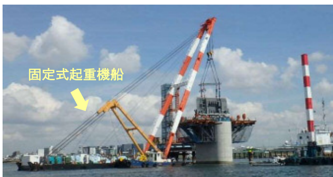
P4橋脚柱頭部架設状況
