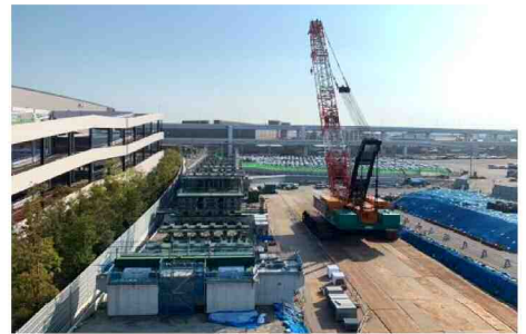
送出し架設ヤード全景 （B1ベントから望む）
