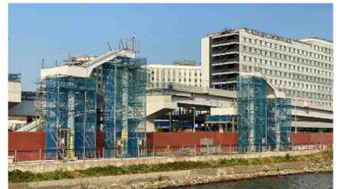
桁架設完了
