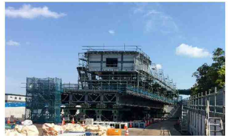
送出し架設ヤード全景 （川崎側陸上ヤードから望む）
