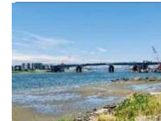
羽田連絡道路 ※R3年度内開通予定
