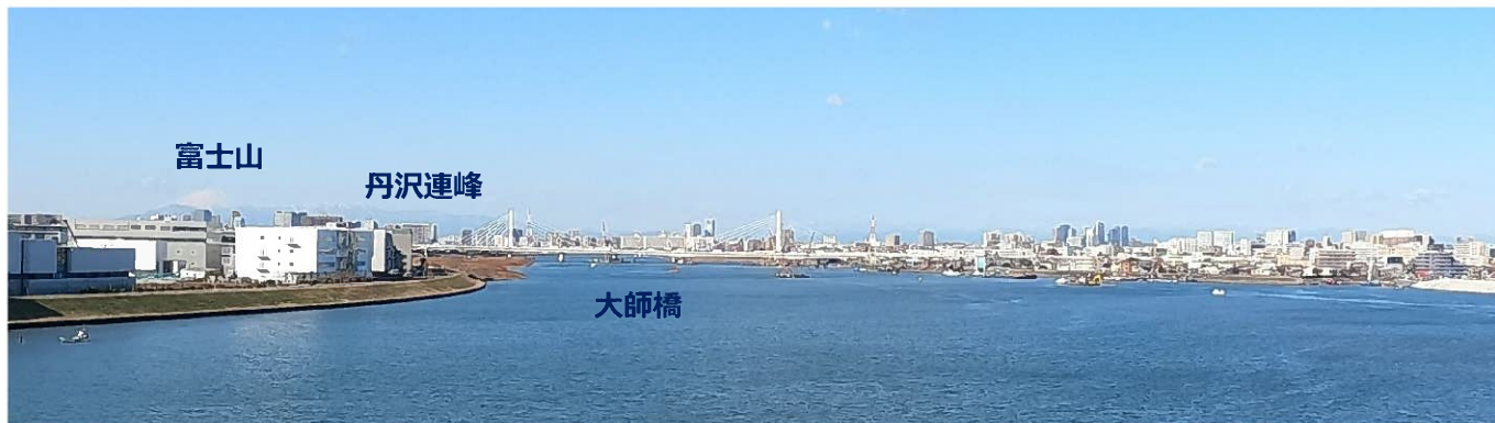
橋上からの眺望 (上流側 2021年1月29日撮影)
