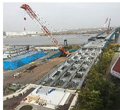
取付部施工状況
