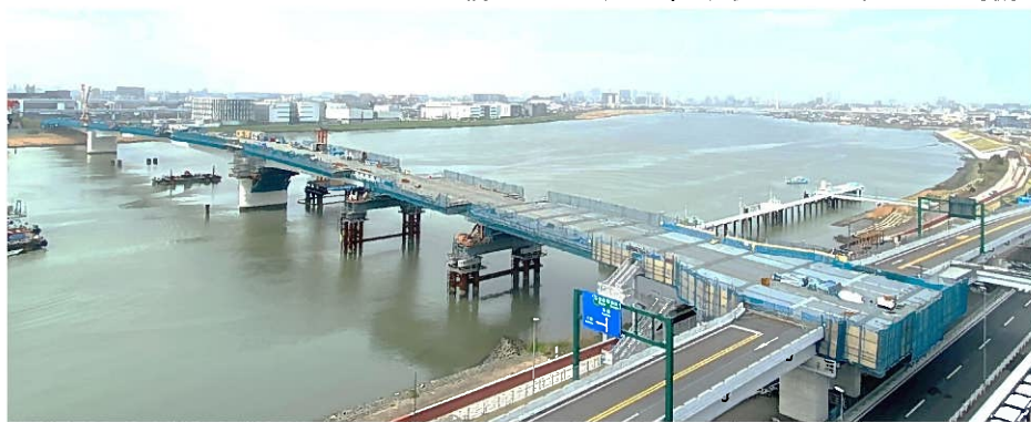
渡河部施工状況 (2021年3月30日撮影)
